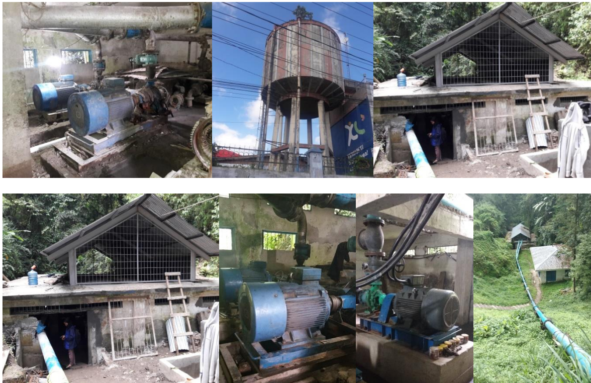
Gambar 2.3.1 Kondisi Bangunan Intake Lau Berneh
