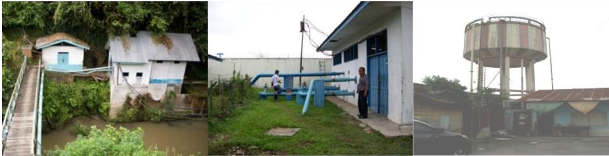
Gambar 2.3.2 Kondisi Bangunan SPAM Lau Bawang 1 dan 2
