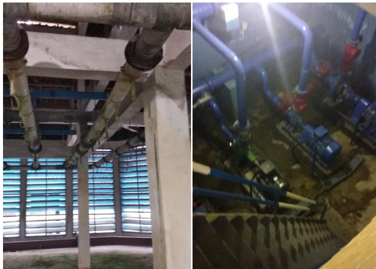
Gambar 2.3.3 Kondisi Eksisting Bangunan Aerasi dan Rumah Pompa Sumber Air Lau Melas 2 (PDAM Tirtanadi)
